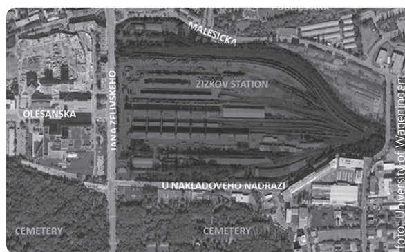
Celkový pohled na Nákladové nádraží Žižkov
